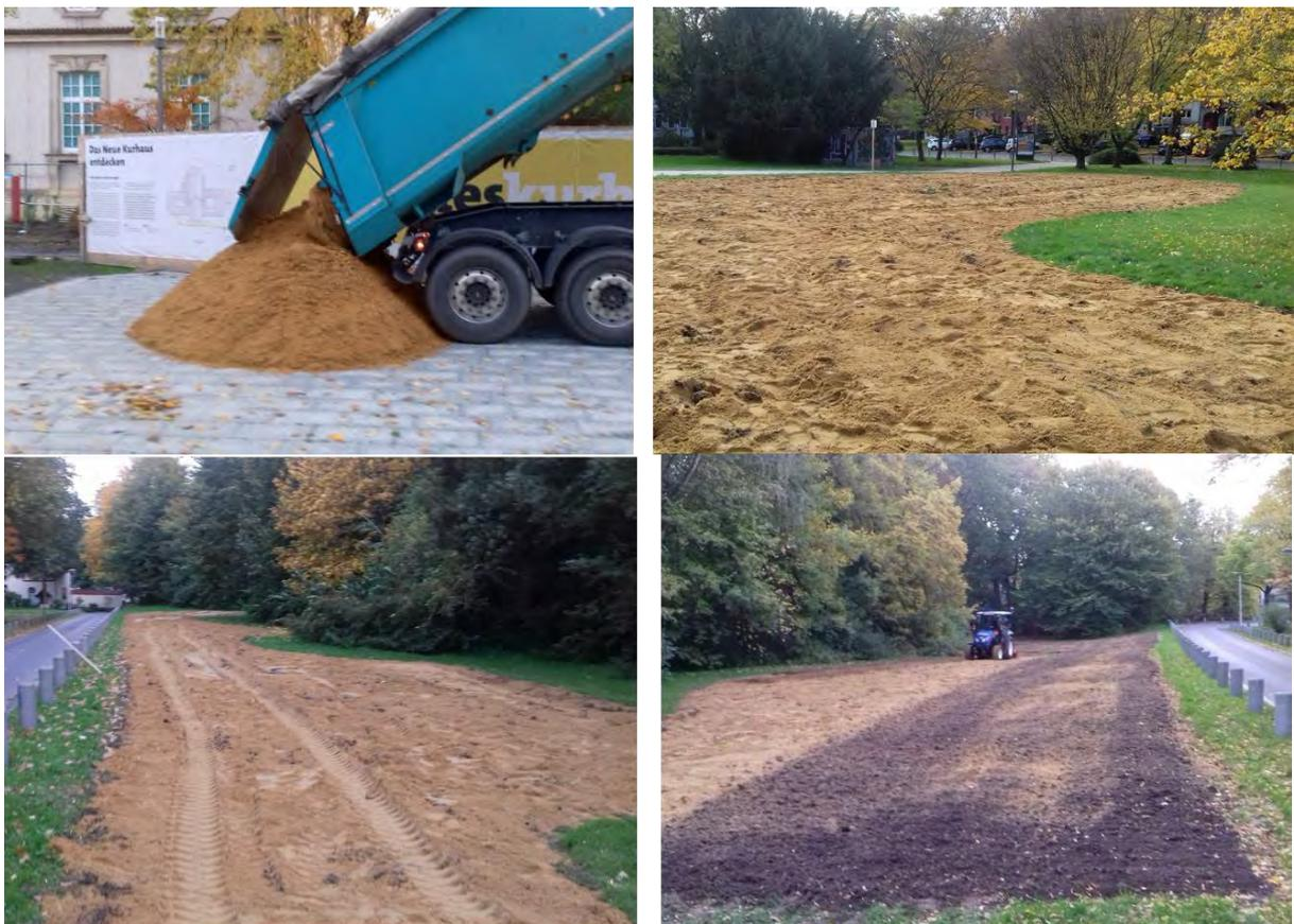
Abbildung 4: Die Bilder zeigen den Prozess des Unterarbeitens von Sand, wie er sich für die Wiesenanlage als sehr hilfreich erwiesen hat.
