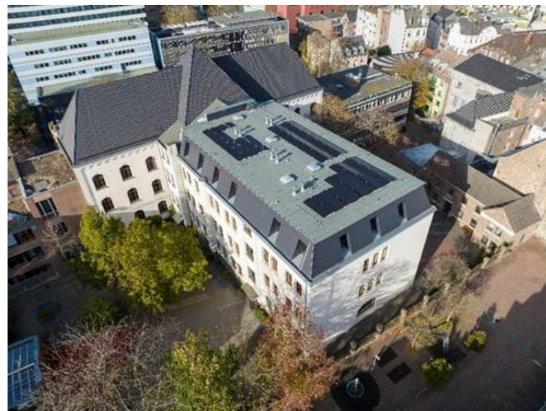
Kaiser- Karls- Gymnasium Dach 3 mit 29 kWp
