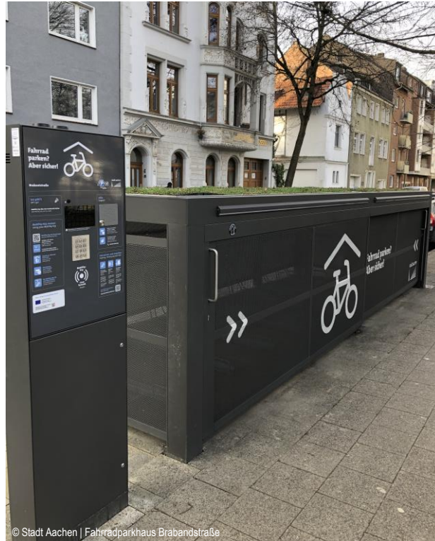
© Stadt Aachen | Fahrradparkhaus Brabandstraße
