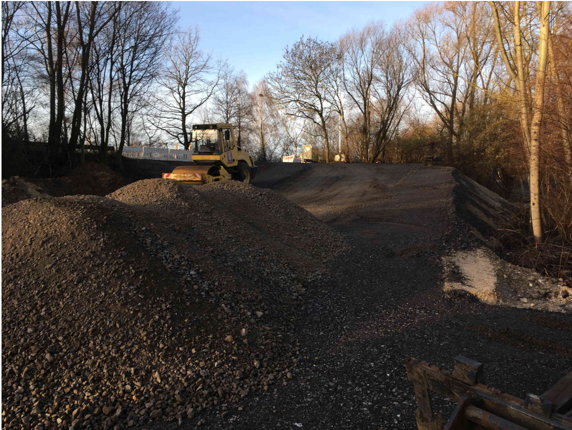
Zufahrtsrampe im Januar 2023 (eigenes Foto, FK)
