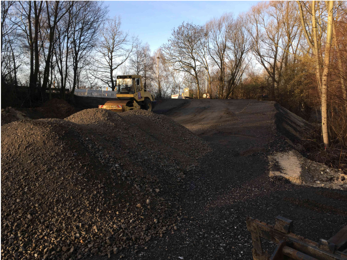
Zufahrtsrampe im Januar 2023 (eigenes Foto, FK)
