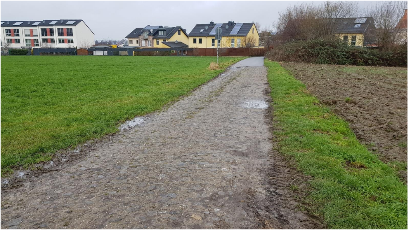
Ende des bisherigen Asphaltausbaus
