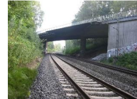
Brücke Horbacher Str.
