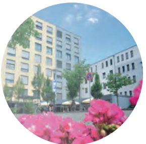
Bethlehem Krankenhaus, Stolberg
