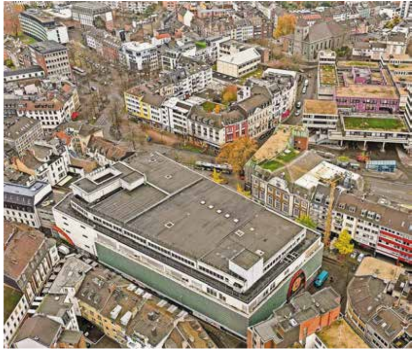
Ein gewaltiges Areal steht vor einem großen Umbruch: Grüne und SPD haben jetzt ihre Pläne für die Innenstadtentwicklung vorgelegt.
