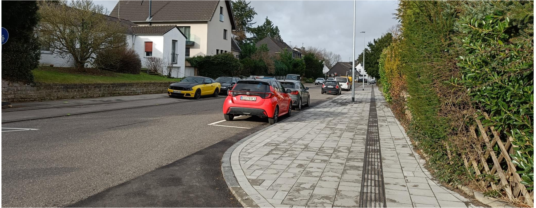
Erneuerung des Gehweg nach Regionetz-Maßnahme
