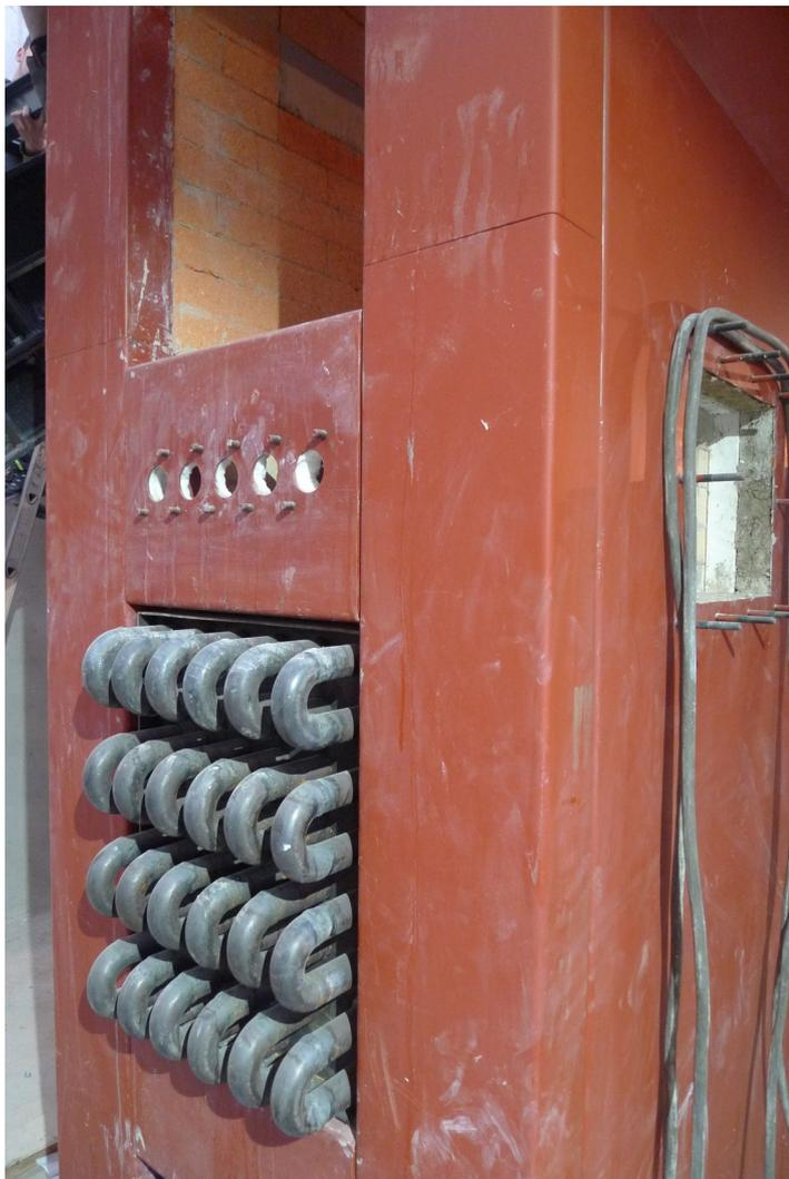
Zu sehen sind die Rohrbündel in denen das Kühlmedium (Wasser bzw. Wasser/Glykol) fließt, sowie die Wendebögen im Kaltbereich. Diese AWTs können sehr spezifisch an die baulichen Gegebenheiten angepasst werden und stellen damit eine Alternative zu Stahlgehäusen dar.
