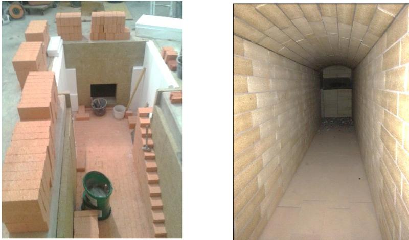
Bild 11: gemauerter Unterflurkanal
