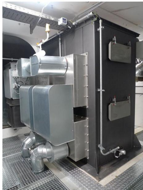
*Bild 13: Ausgeführter zweizügiger gemauerter Wärmetauscher, auf Abgaskanalsockel (Krematorium Heilbronn. 2021) (links: Bauphase, rechts: Betrieb)*
