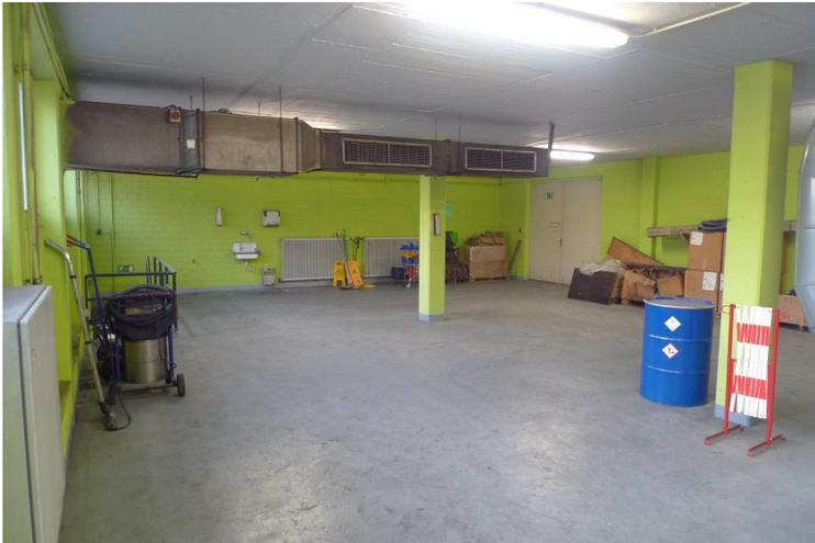
Bild 1: Zu sehen ist die derzeitige Abluftleitung im Bereich EG ohne Wärmerückgewinnung. Die Abluftanlage ist zu schwach. Es kommt zu erheblichem Wärmestau
