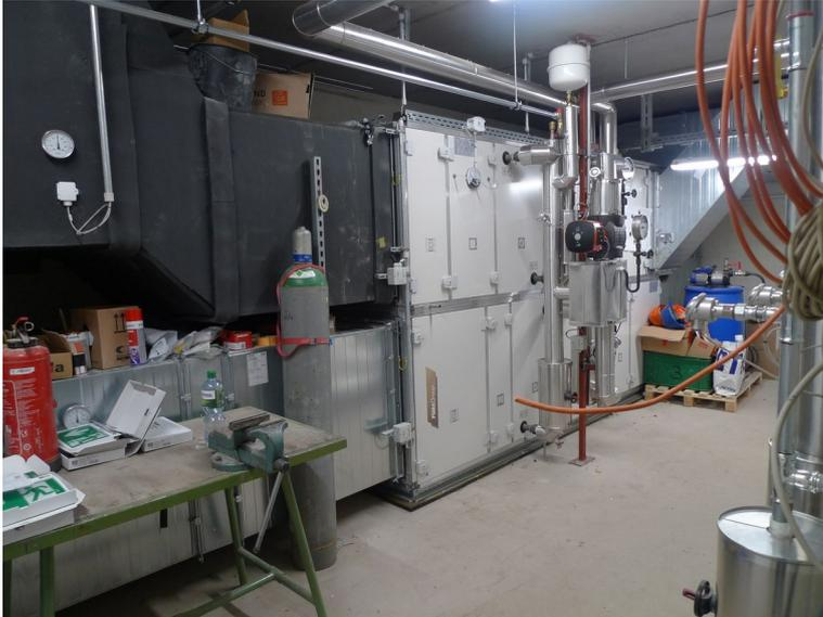
*Bild 3: Aufnahme der beiden Lüftungsanlagen (Zu-/Abluft), aus der Bauphase Krematorium Bielefeld. Die Anlagen müssen nicht übereinander stehen.*
