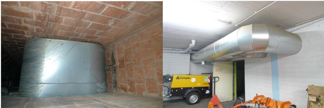
Bild 16: Reingaskaminanschluss
