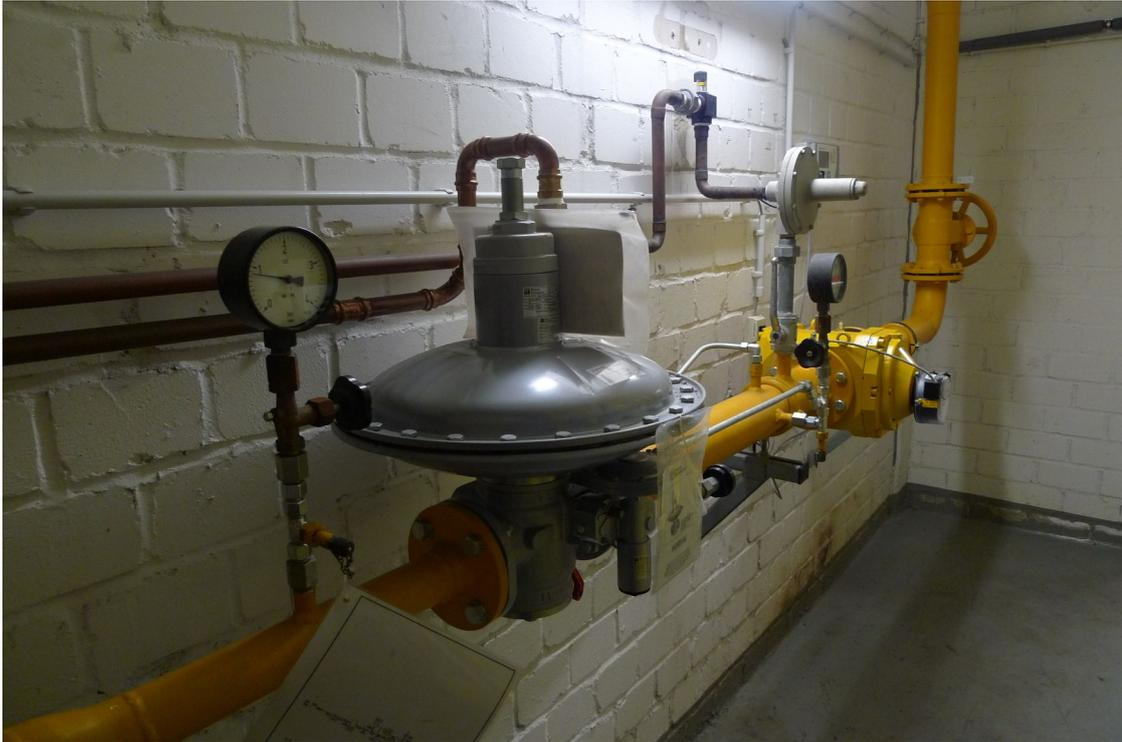
Bild der derzeitigen Gaseinspeisung. Am Manometer ist ein Einspeisedruck von 900 mbar zu sehen, der derzeit dann auf ca. 30 mbar reduziert wird.
