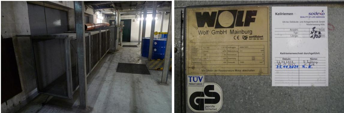
**Bild 5:** Zuluftanlage im Bestand im 2.UG. Diese Anlage hat eine Leistung von 15.000 m<sup>3</sup>/h (Anlage hier genannt WOLF-15000).
