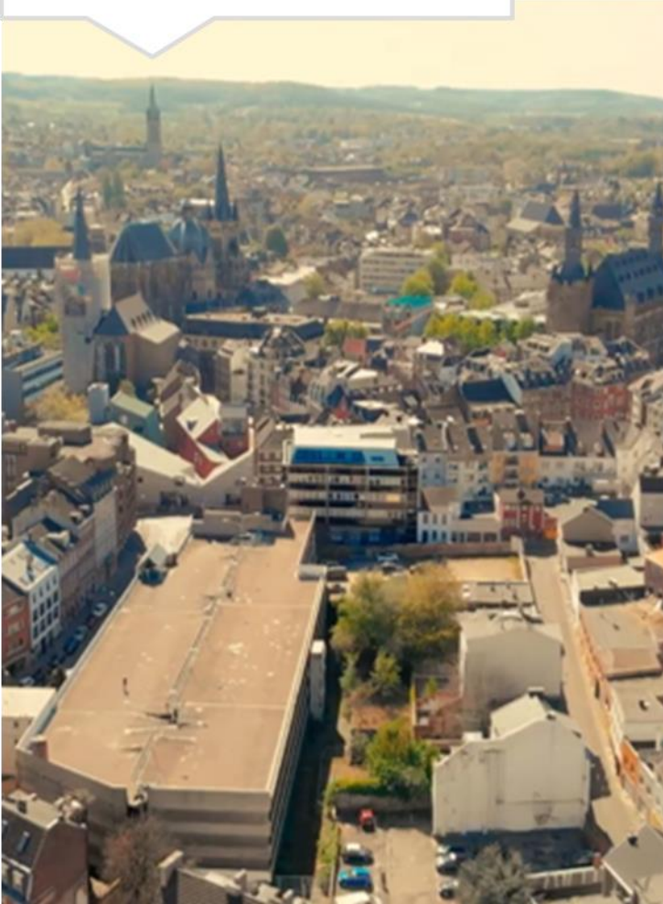
Parkhaus vor Abbruch
