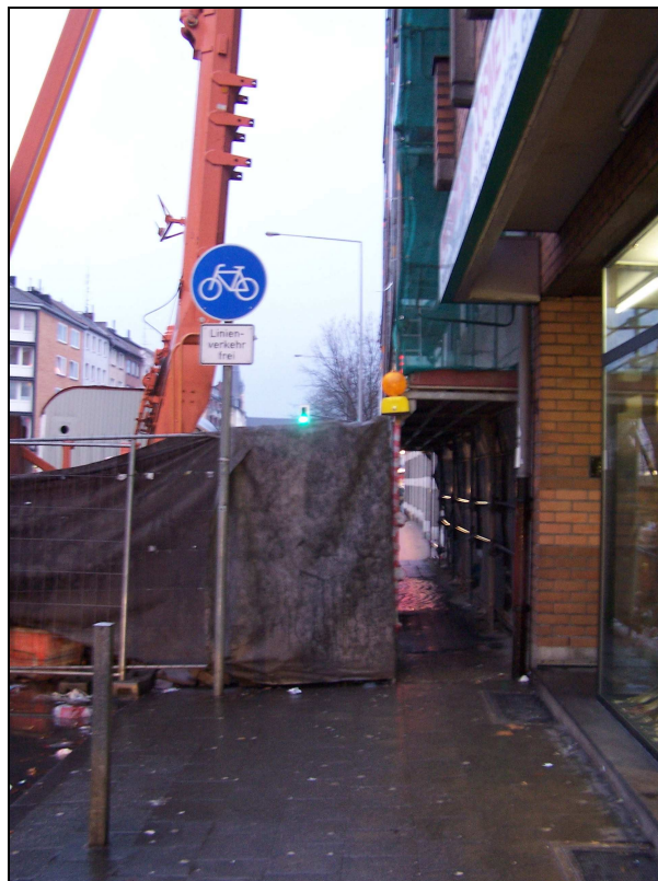
Abb. 1: Beschilderung am Knotenpunkt Jülicher Straße/Ottostraße: Radfahrstreifen mit Freigabe für den Linienverkehr (Zeichen 237 „Sonderweg Radfahrer“ mit Zeichen 1026-32 „Linienverkehr frei“ der StVO)
